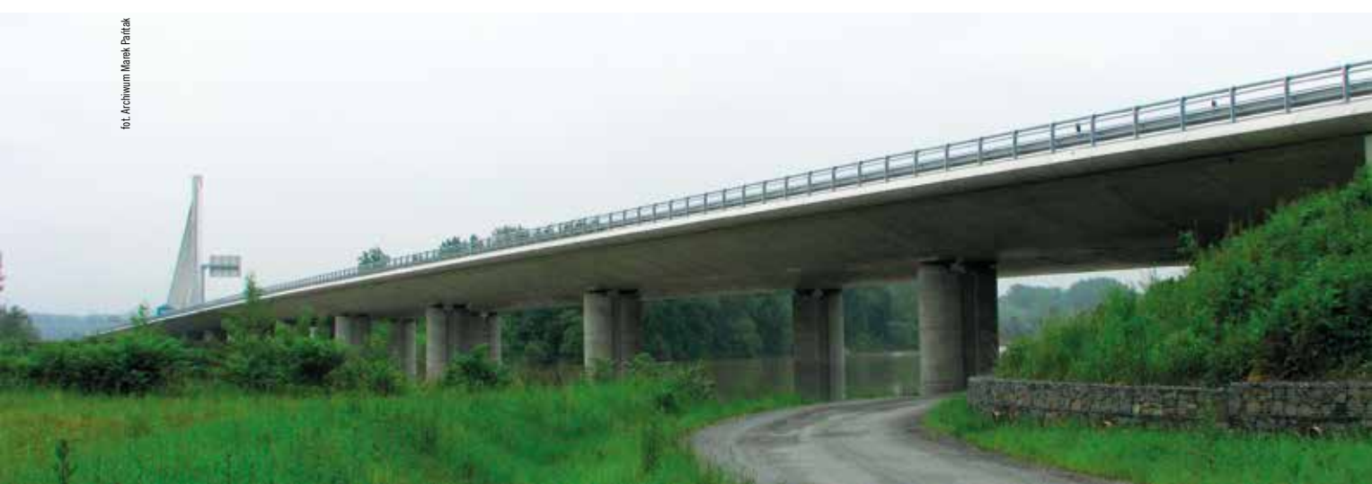
Fot. 5. Podwieszony most autostradowy przez Odrę i jezioro Antoszowickie
