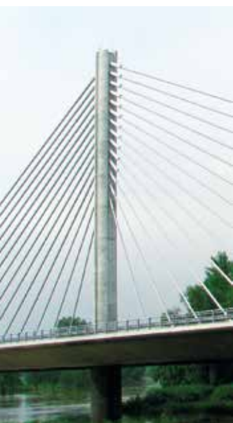
Fot. 8. Podwieszony most autostradowy przez Odrę i jezioro Antoszowickie
