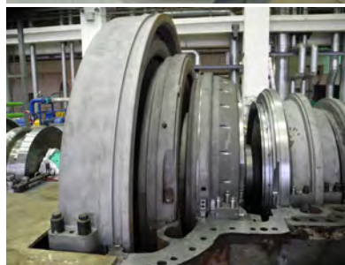
Fot. 1. Tarcza kierownicza z regulowaną przysłoną przed i po montażu
