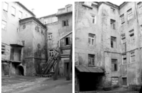
Ryc. 5. Wnętrze kwartału, stan budynków w 2002 roku
