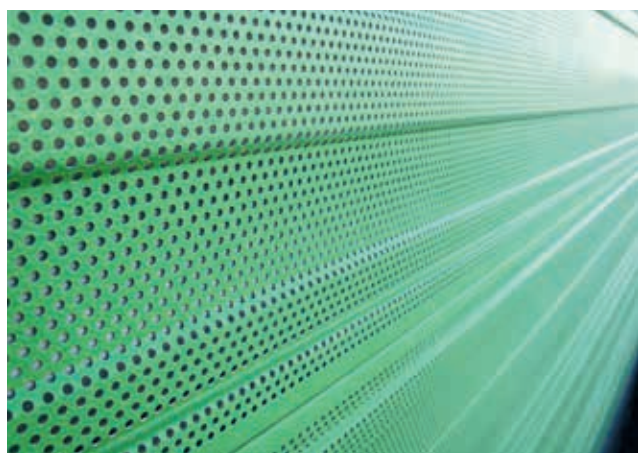
Ryc. 11. Przykład panelu absorbującego hałas, możliwego do zastosowania w obrębie przejść dla zwierząt, fot. A. Wysokowski
