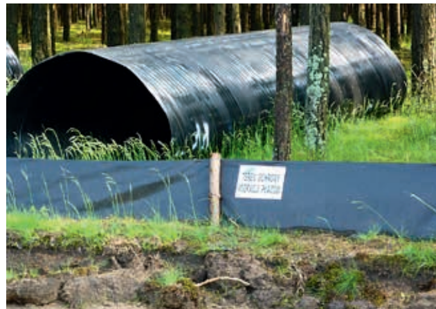
Ryc. 10. Przykład tymczasowej ochrony prowadzonej inwestycji za pomocą tymczasowych płotków ochronnych dla herpetofauny, wykonanych z tworzyw sztucznych, fot. A. Wysokowski
