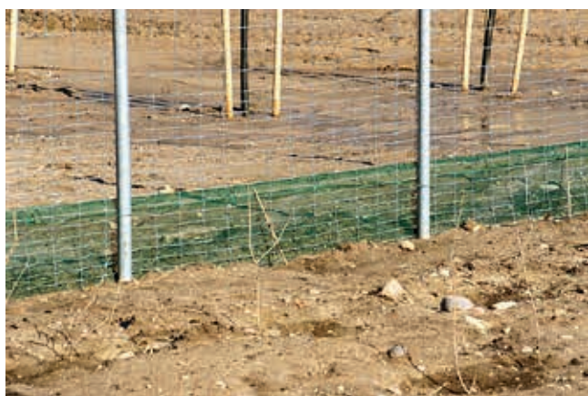
Ryc. 8. Przykładowe rozwiązanie siatki naprowadzającej w postaci siatki stalowej, uzupełnionej przez dogęszczoną siatkę z tworzyw sztucznych dla herpetofauny, fot. A. Wysokowski
