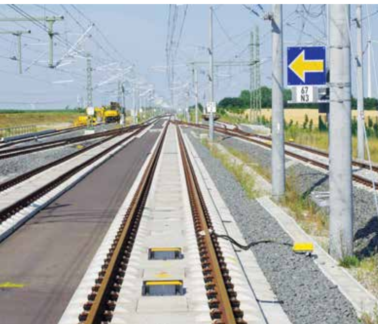
Stacja techniczna Jüdendorf. Widoczna nawierzchnia bezpodsypankowa typu ÖBB-PÖRR oraz wskaźniki przytorowe ETCS. Źródło: DB AG.
