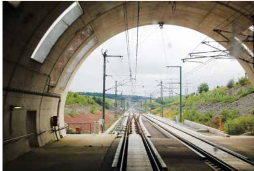
Wylot z tunelu Blessberg Źródło: DB AG.
