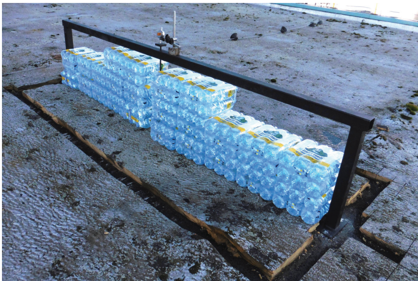
Fot. 4. Widok stanowiska badawczego podczas próbnego obciążenia płyt korytkowych
