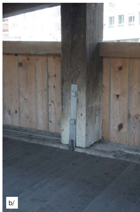
Fot. 5. Konstrukcja nośna najstarszego przęsła: a/ dźwigary łukowe i słupko-wieszaki, b/ współczesne wzmocnienie wieszaków
