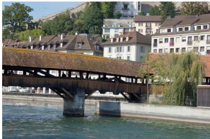
Fot. 8. Różne pochylenie górnych zastrzałów dźwigarów trójkątno- i trapezowo-zastrzałowych oraz dolnych zastrzałów rozpornicy
