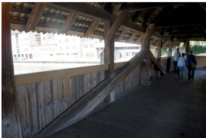
Fot. 6. Trójkątno-zastrzałowe dźwigary przęsła drugiego
