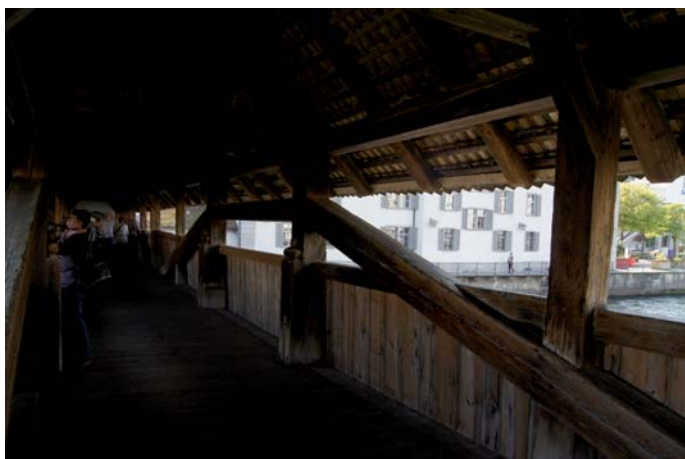
Fot. 7. Trapezowo-zastrzałowe dźwigary dwóch przęseł lewobrzeżnych
