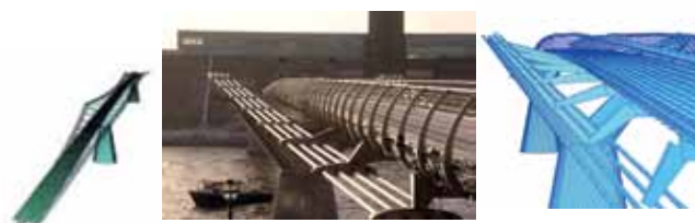
Rys. 2. Most Milenijny w Londynie zaprojektowany przez Ove Arup&Partners; widok na podporę i belkowy model numeryczny MES SOFiSTiK
