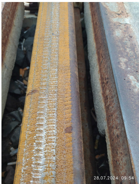
Rys. 5. Chropowatość powierzchni szyny po reprofilacji Fig. 5. Rail surface roughness after reprofiling
