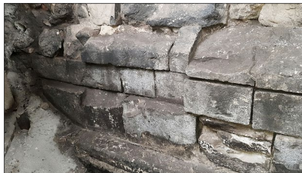
Ryc. 6. Zachowany fragment frontowej elewacji z ciosów kamiennych II romańskiej bazyliki pw. Trójcy Świętej i Marii Panny, wykop archeologiczny przy zachodniej elewacji kolegiaty w Wiślicy, 2020; fot. autorzy
