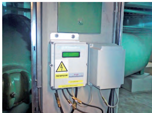
Rys. 1. Przepływomierz ultradźwiękowy: po lewej – głowice przepływomierza, po prawej – jednostka centralna
