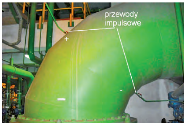
Rys. 4. Układ przepływomierza kolanowego
