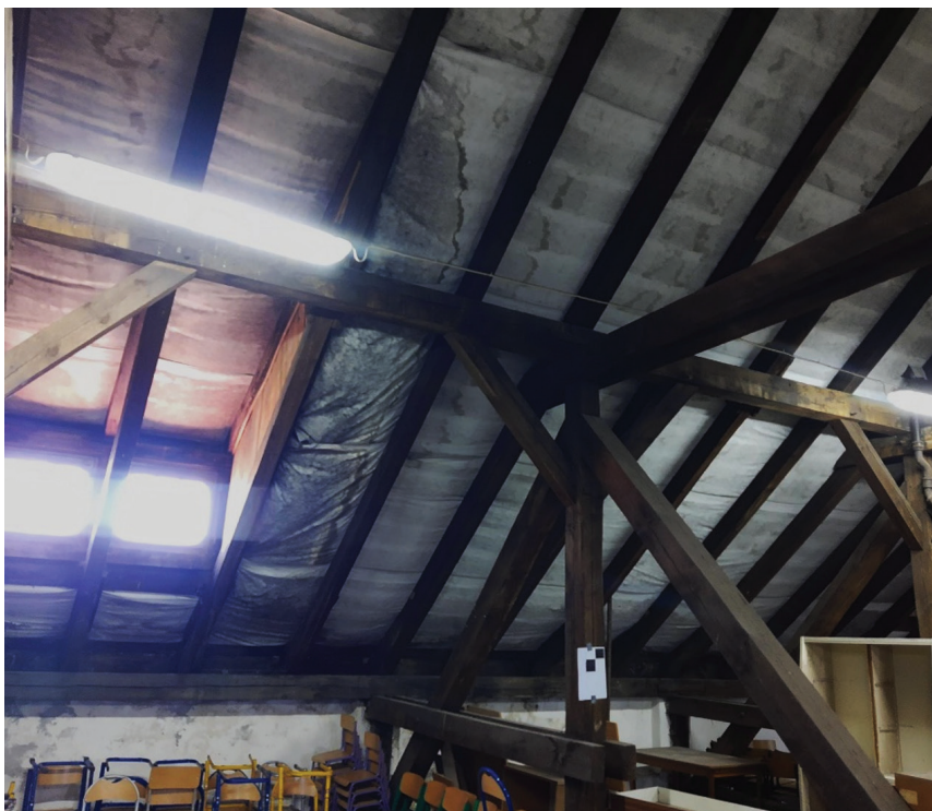
Rys. 3. Zdjęcie więźby dachowej wykonane za pomocą aparatu fotograficznego
