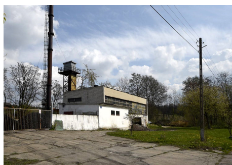
Rys. 3. Kotłownia (fotografia własna) Fig. 3. Boiler house (own photography)
