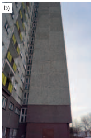
Rys. 2. Czekające na termomodernizację budynki wysokie na os. Śmiałego. System Rataje. Widoczna charakterystyczna elewacja, w której w części podłużnej zastosowano elementy wielkoblokowe, a na szczytach typowe elementy wielkopłytkowe, 2020 r.
