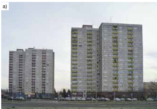
Rys. 2. Czekające na termomodernizację budynki wysokie na os. Śmiałego. System Rataje. Widoczna charakterystyczna elewacja, w której w części podłużnej zastosowano elementy wielkoblokowe, a na szczytach typowe elementy wielkopłytkowe, 2020 r.
