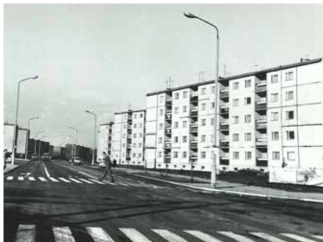
Rys. 4. Czteropiętrowe budynki przy ul. Grochowskiej od ul. Marcelińskiej, system PBU, fot. S. Leszczyński, 1968 r. ze zbiorów Biura MKZ w Poznaniu)
