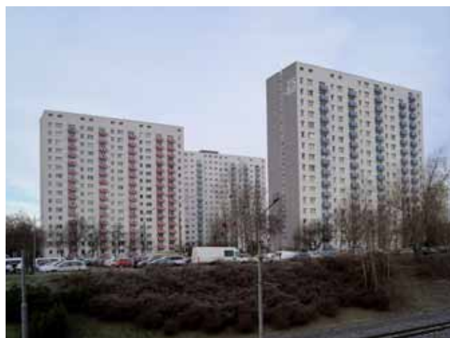
Rys. 1. Wyremontowane elewacje budynków wysokich na os. Chrobrego, system Winogrody, 2020 r.
