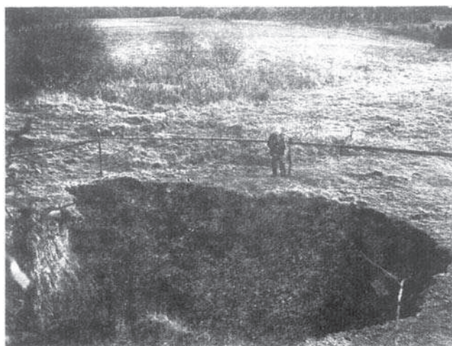
Rys. 12. Zapadlisko w miejscu jednego z szybów Schloin, okolice Buchalowa, lata 70. XX w. fot. I. Wróbel.
