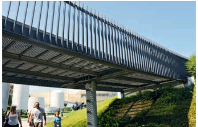
Kładka z ażurowym pomostem w Tuluzie (obiekt nr 8)
