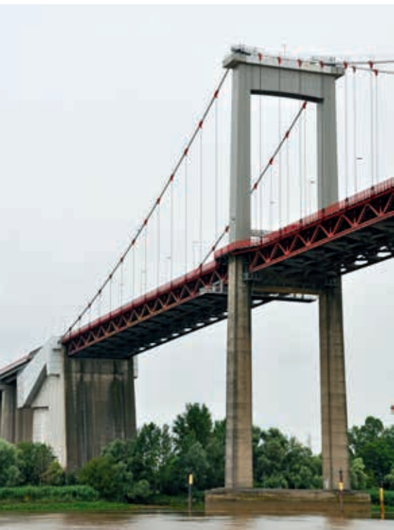
Pylon pont d'Aquitaine (obiekt nr 13)
