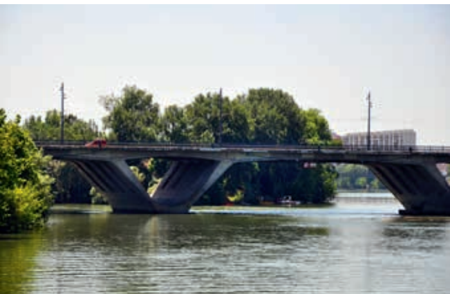
Pont Saint-Michel przez Garonę w Tuluzie (obiekt nr 6)
