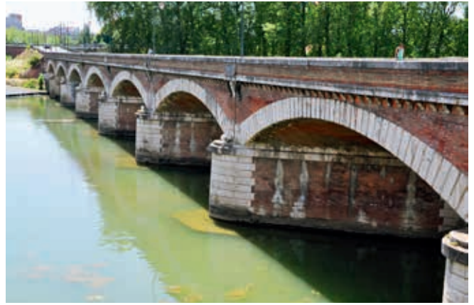
Pont de halage de Tounis (obiekt nr 7)
