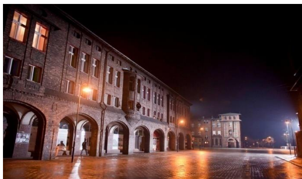
Rys. 1. Zabytkowe osiedle Nikiszowiec w Katowicach
