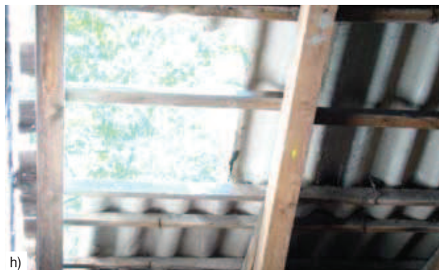
Rys. 4. Budynek Administracyjno-Koszarowy: a) widok ogólny, b) zawilgocenie murów zewnętrznych w poziomie piwnicy, uszkodzenia stropu gęstożebrowego c) nad piwnicą, d) nad parterem, zapadnięcia stropu na belkach drewnianych, e) nad parterem, f) nad I piętrzem, g) nad II piętrzem, h) uszkodzenia pokrycia dachowego oraz zawilgocenie drewnianej więźby dachowej
