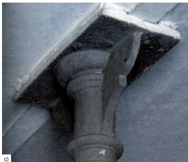
Rys. 2. Detale architektoniczno-konstrukcyjne występujące w budynkach dawnych Koszar czarnych Huzarów: a) gwiazda z sentencją Suum cuique (Każdemu, co mu się należy), b) ozdobna krata nad wejściem do budynku, c) rozrzeźbiona głowica słupa żeliwnego, d) kółko do przywiązywania koni na elewacji Stajni (tzw. koniowiąz)
