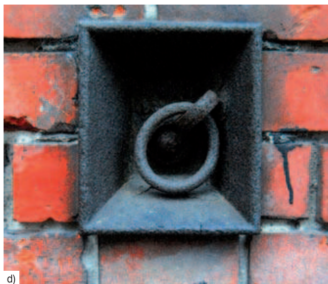
Rys. 2. Detale architektoniczno-konstrukcyjne występujące w budynkach dawnych Koszar czarnych Huzarów: a) gwiazda z sentencją Suum cuique (Każdemu, co mu się należy), b) ozdobna krata nad wejściem do budynku, c) rozrzeźbiona głowica słupa żeliwnego, d) kółko do przywiązywania koni na elewacji Stajni (tzw. koniowiąz)
