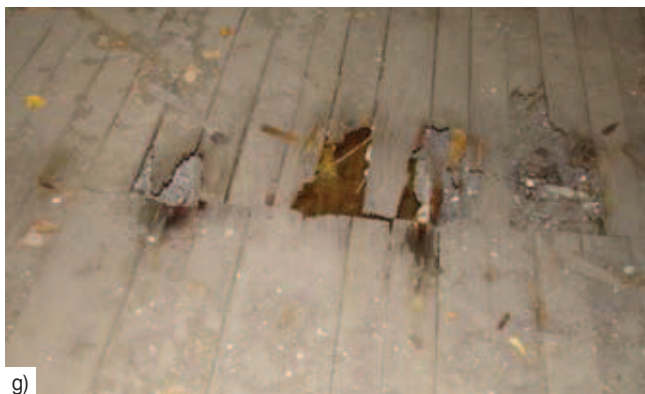
Rys. 4. Budynek Administracyjno-Koszarowy: a) widok ogólny, b) zawilgocenie murów zewnętrznych w poziomie piwnicy, uszkodzenia stropu gęstożebrowego c) nad piwnicą, d) nad parterem, zapadnięcia stropu na belkach drewnianych, e) nad parterem, f) nad I piętrzem, g) nad II piętrzem, h) uszkodzenia pokrycia dachowego oraz zawilgocenie drewnianej więźby dachowej
