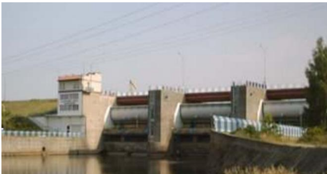
Rysunek 10 Elektrownia wodna na Zalewie Sulejowskim w Smardzewicach. Źródło: materiały własne.
