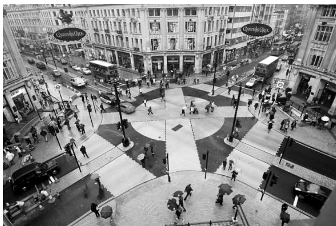
Fot. 2. Przejścia diagonalne na skrzyżowaniu Oxford Circus w Londynie [4]
