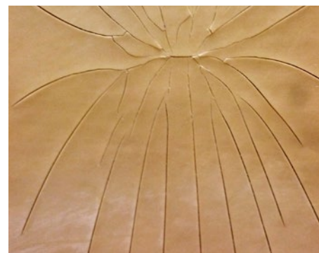
Ryc. 12. Pęknięcia wewnętrznej warstwy żywicznej w rurze GRP (zdjęcie rury będącej w posiadaniu autora)
