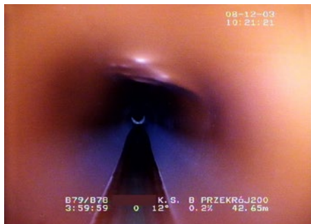
Ryc. 15. Wbijanie się kilku kamieni w ściankę rury PVC, fot. A. Kuliczkowski
