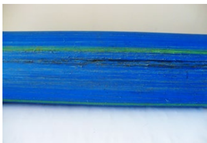
Ryc. 10. Zarysowana rura polietylenowa po przecięciu jej przez warstwę gruntu, będąca w posiadaniu autora artykułu, fot. A. Kulickowski
