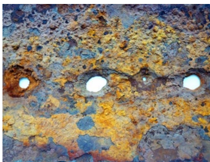
Ryc. 9. Próbkę skorodowanej rury stalowej z wżerami na wylot, pobrana podczas jednej z ekspertyz wykonywanych przez autora artykułu, fot. A. Kulickowski
