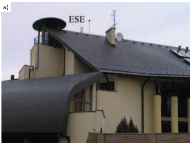
Rys. 8. Zwód ESE na budynku mieszkalnym we Wrocławiu
