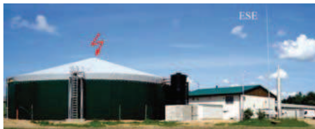
Rys. 6. Stacja biogazu w Malsicach w Czechach. Miejsce uderzenia pioruna zaznaczono czerwoną błyskawicą, napis ESE wskazuje położenie maszty z głowicą aktywną [12]
