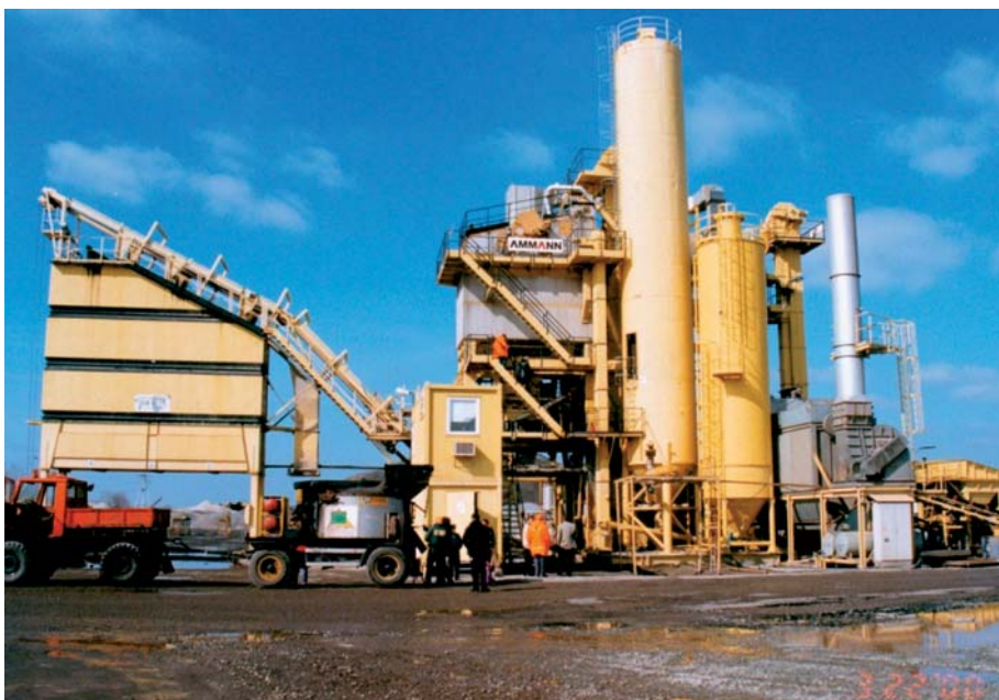
Fot. 5. Widok wytwórni mieszank mineralno-asfaltowych AMMAN Quick 180/240 , przed którą stoi kocioł transportowy z mieszanką asfaltu lanego, przeznaczonego do wykonania warstwy ochronnej hydroizolacji oraz warstwy ścieralnej na pomostach wiaduktów autostradowych (fot. K. Jabłoński)
