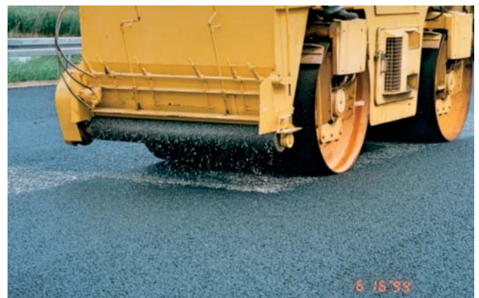
Fot. 3. Widok posypywania, rozłożonej mieszanki mastyksowo-grysowej SMA 0/12,8 grysem 2/5, przy pomocy rozsypywarki zamocowanej na stalowym walcu tandemowym (fot. K. Jabłoński)
