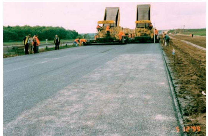
Fot. 1. Wbudowywanie mieszanki mastyksowo-grysowej SMA 0/12,8 dwoma układarkami; na pierwszym planie zagęszczony pas warstwy ścieralnej z SMA posypywany grysem 2/5 (fot. K. Jabłoński)
