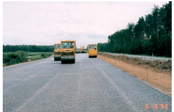
Fot. 2. Zagęszczanie mieszanki mastyksowo-grysowej SMA 0/12,8 stalowymi walcami tandemowymi; walec po prawej stronie wyposażony w rozsypywarkę grysu 2/5 (fot. K. Jabłoński)
