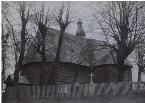
Rys. 4. Widok kościoła od południowego zachodu, fotografia z przed 1939 r. Źródło: WUOZ w Opolu [4]
