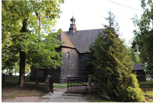
Rys. 8. Widok kościoła od zachodu. Fot. M. Tunkel, 2021
