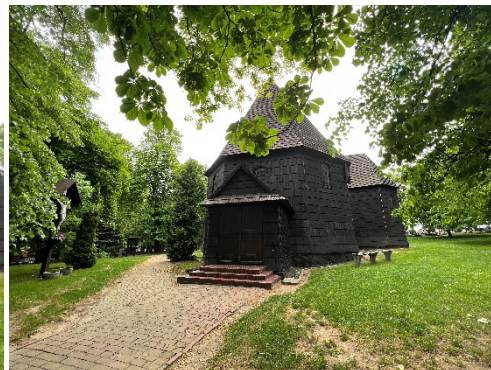
Rys. 13. Widok kościoła od zachodu. Fot. M. Tunkel, 2021
