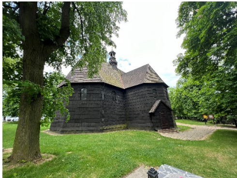
Rys. 10. Widok kościoła od północy. Fot. T. Orłowski, 2022
