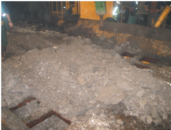
Rys. 4. Krata po wyladowaniu urobku przez ładowarkę łyżkową LKP-0903
