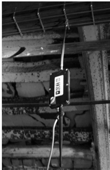
Rys. 3.5 Pierwszy repeater sieci połączony do bazy kablem optycznym z mediakonwerterem
