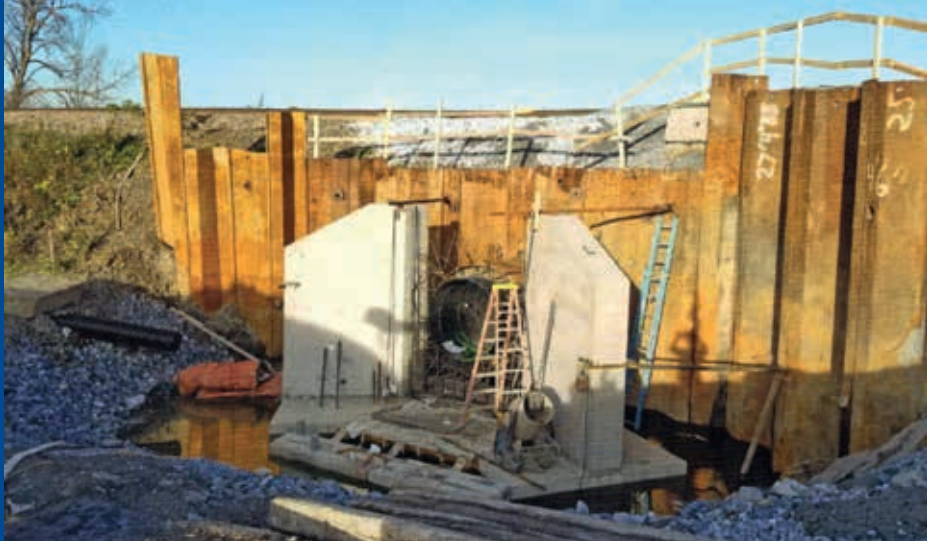
Ryc. 1. Przepust pod torami kolejowymi na etapie wbudowania
