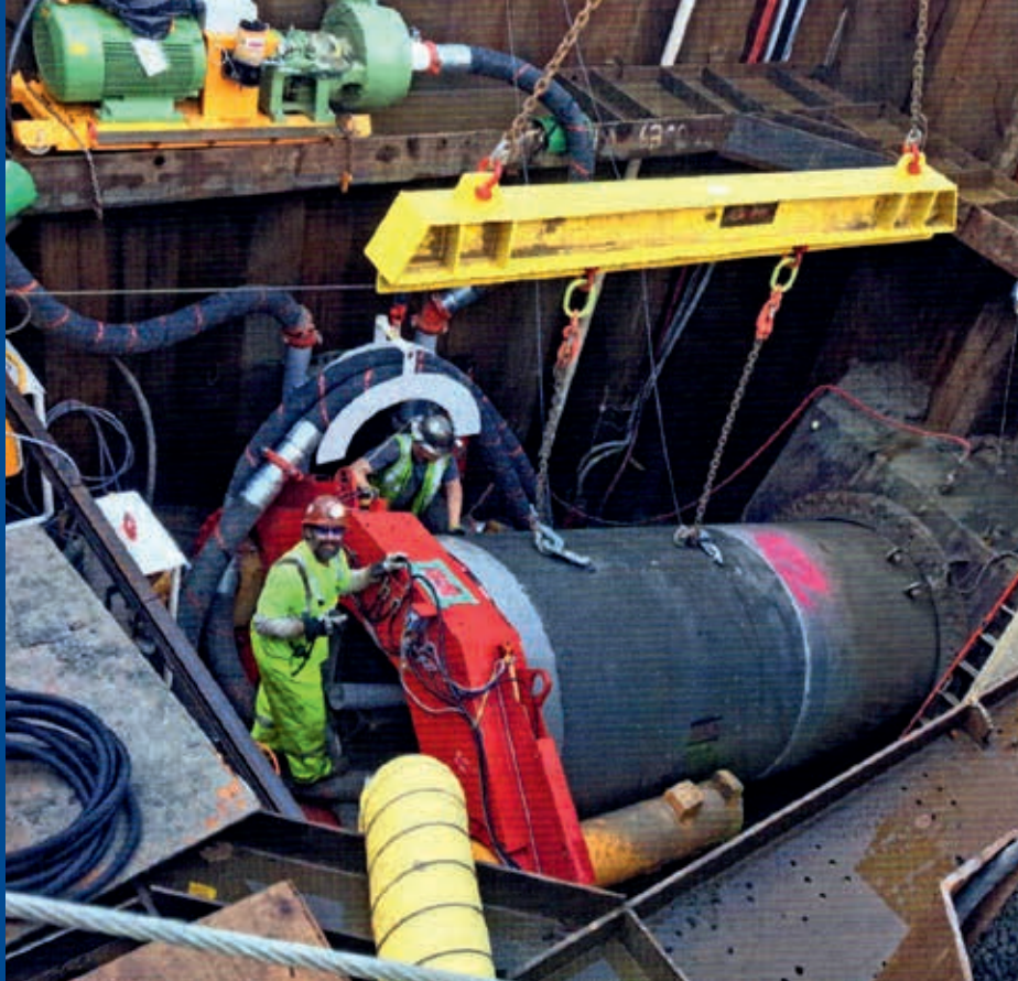
Ryc. 3. Wprowadzenie głowicy MTBM do wykopu początkowego
