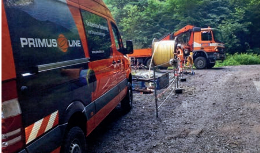
Ryc. 2. Przeprowadzenie rehabilitacji gazociągu w trudno dostępnym obszarze leśnym
