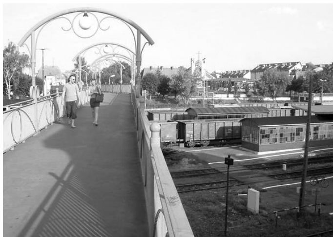
Fot. 3. Kładka piesza łącząca dwie części Kwidzyna nad stacją kolejową pozbawiona jest bezpośrednich zejść na perony (fot. Michał Beim)
