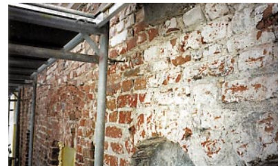
Zabrudzenia powierzchni wątków ceglanych i ich usuwanie
