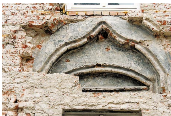
Pozostałości błękitnego wymalowania w blendach
