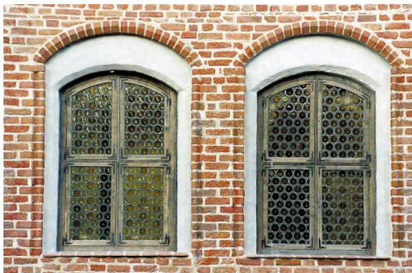
Szklenie gomółkowe okien pierwszego piętra i stolarka parteru elewacji wschodniej
