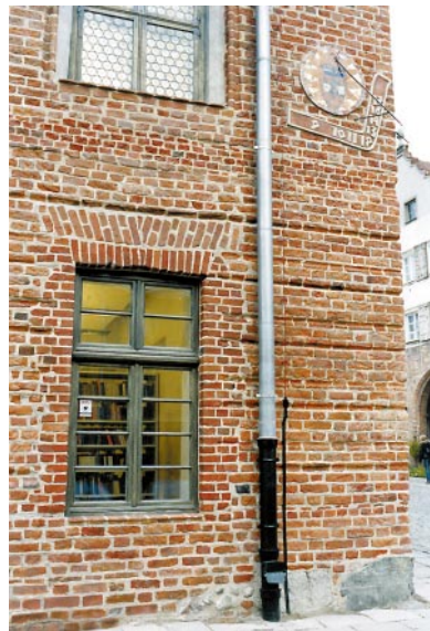
Fragment elewacji południowej przed i po konserwacji, z widocznymi bruzdami po boniowaniu
