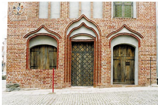
Szklenie gomółkowe okien pierwszego piętra i stolarka parteru elewacji wschodniej
