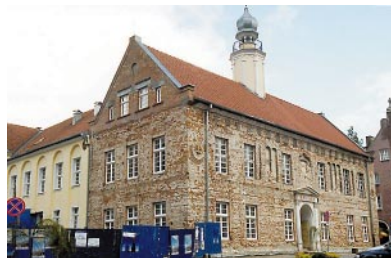
Stary Ratusz w Olsztynie. Strona południowo-zachodnia. Stan po usunięciu tynków
