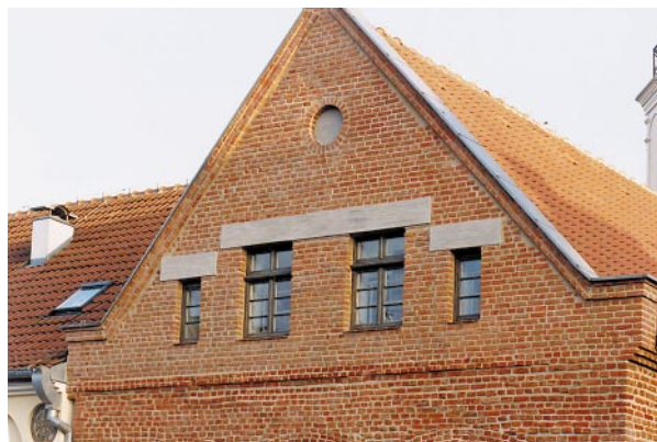
Szczyt elewacji zachodniej po konserwacji
