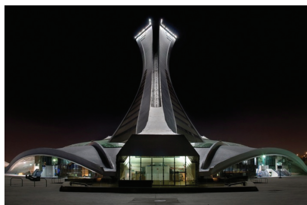
Il. 2. Dynamika wizualna kształtu Wieży Olimpijskiej wraz z przyległymi powłokami żebrowymi, kryjącymi we wnętrzu pływalnię olimpijską (fot. Acarpentier; http://upload.wikimedia.org/wikipedia/commons/6/64/Le_Stade_Olympique_de_Montr%C3%A9al_Nuit_Arriere_Edit_1.jpg , CC BY 3.0)
