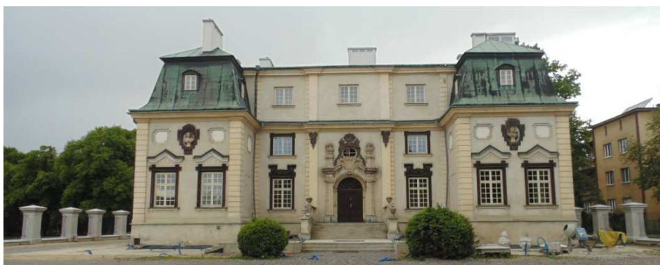
Rys. 1. Widok elewacji frontowej (wschodniej) przed remontem
