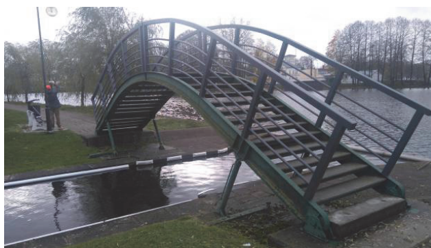
Rys. 9. Istniejąca kładka KP-3
