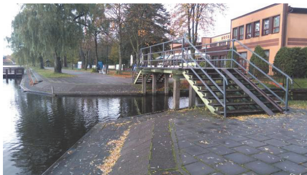
Rys. 5. Istniejąca kładka KP-1
