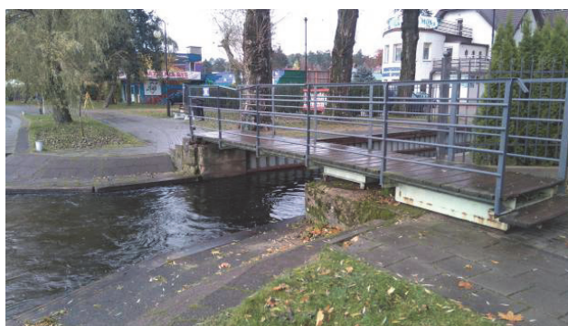
Rys. 7. Istniejąca kładka KP-2
