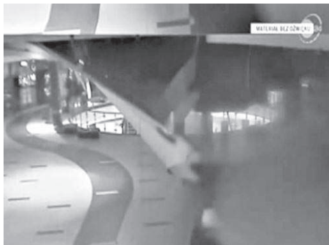
Rys. 1. Moment katastrofy w galerii handlowej „Avenida”. Widoczne jest oberwanie się sufitu wykonanego z płyt gipsowo-kartonowych
