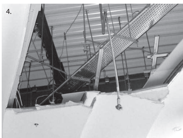
Rys. 2–5. Widok wnętrza budynku galerii „Avenida” (drugie piętro, rejon awarii). Widoczne uszkodzone fragmenty instalacji tryskaczowej oraz sufitu podwieszanego (płyt g-k)
