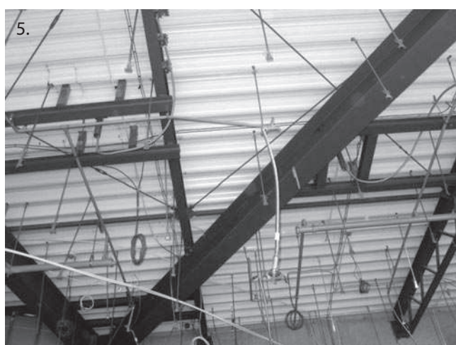
Rys. 2–5. Widok wnętrza budynku galerii „Avenida” (drugie piętro, rejon awarii). Widoczne uszkodzone fragmenty instalacji tryskaczowej oraz sufitu podwieszanego (płyt g-k)
