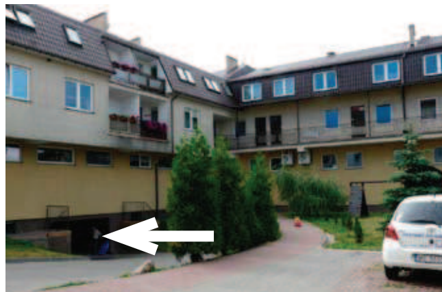
Rys. 2. Ogólny widok budynku mieszkalno-usługowego od strony podwórza (strzałką zaznaczono wjazd do hali garażowej)
