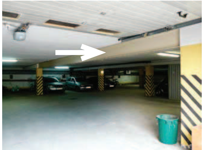
Rys. 3. Widok wnętrza hali garażowej od strony wjazdu (strzałką zaznaczono podciąg stalowy w miejscu, gdzie zrezygnowano ze słupa)
