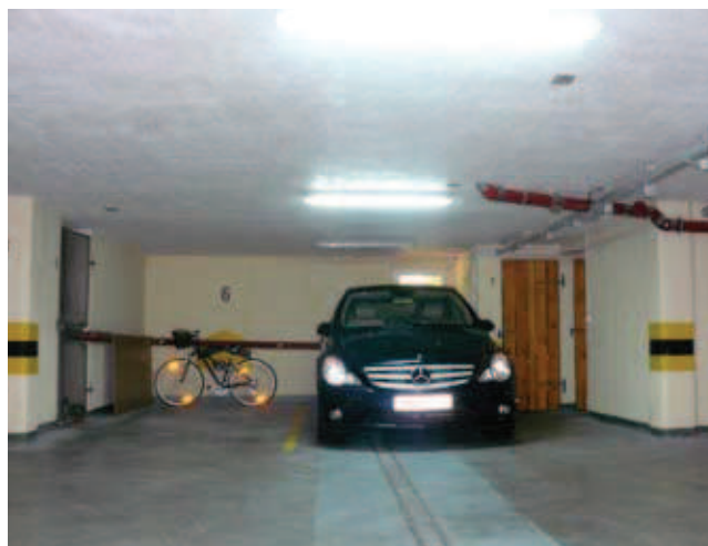
Rys. 7. Widok wnętrza hali garażowej w miejscu usytuowanym bezpośrednio pod ścianą rozdzielającą mieszkania nr 2 i nr 3 na parterze
