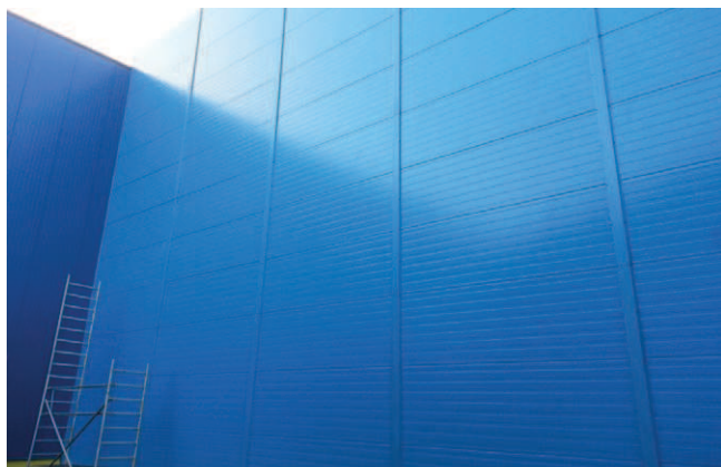
Rys. 7. Ściana budynku po wymianie płyt
