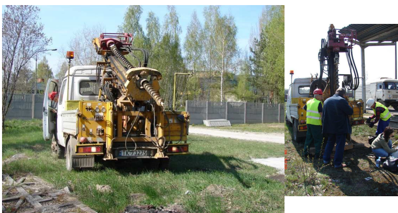
Pobieranie próbek gruntu metodą otworową z wykorzystaniem wiertni samojezdnej
