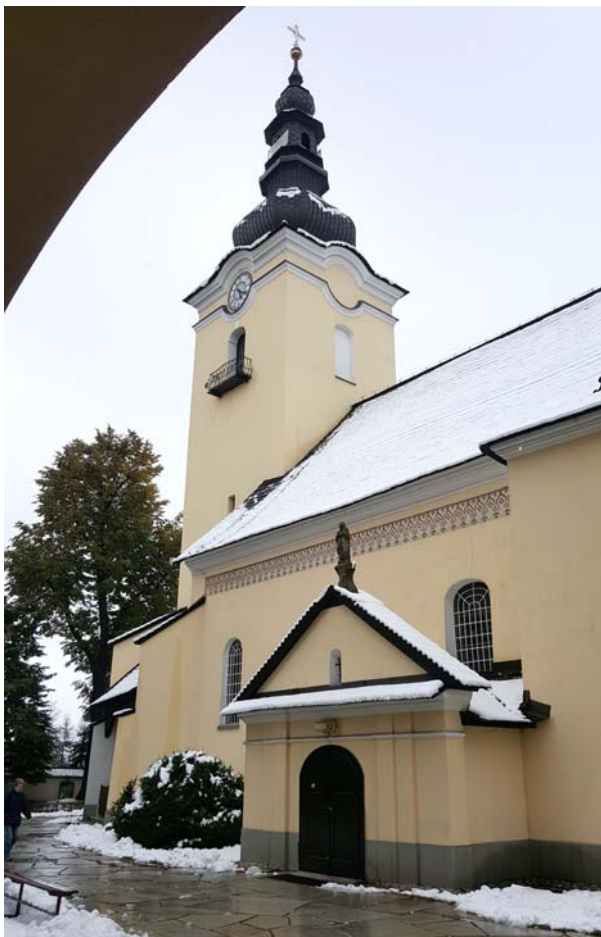
Ryc. 5. Widok na kościół pw. św. Katarzyny w Nowym Targu. Fot. autor, 2016
