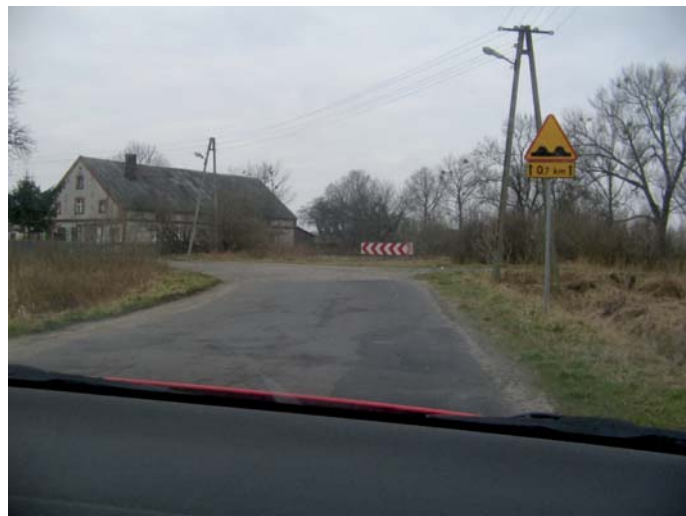
Fot. 10. Droga wojewódzka nr 122 w m. Żarczyn przed inwestycją (2008 r.) – archiwum ZZDW [4]
