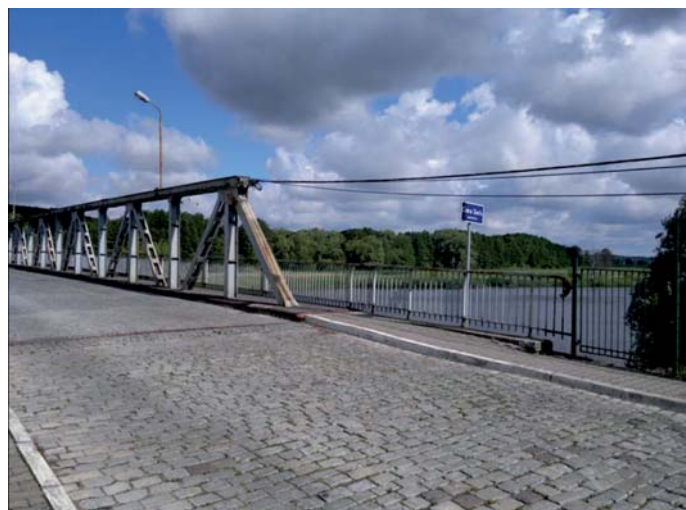
Fot. 7. Most na Odrze Zachodniej w ciągu drogi wojewódzkiej nr 120 (sierpień 2012 r.) – archiwum ZZDW [4]
