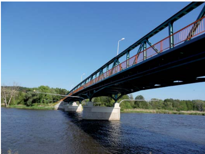
Fot. 8. Most na Odrze Zachodniej w ciągu drogi wojewódzkiej nr 120 w Gryfinie (czerwiec 2013 r.) – archiwum własne
