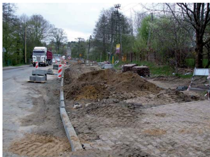
Fot. 3. Droga wojewódzka nr 115 w Pilchowie w trakcie prowadzonych robót budowlanych (kwiecień 2010 r.) – archiwum ZZDW [4]
