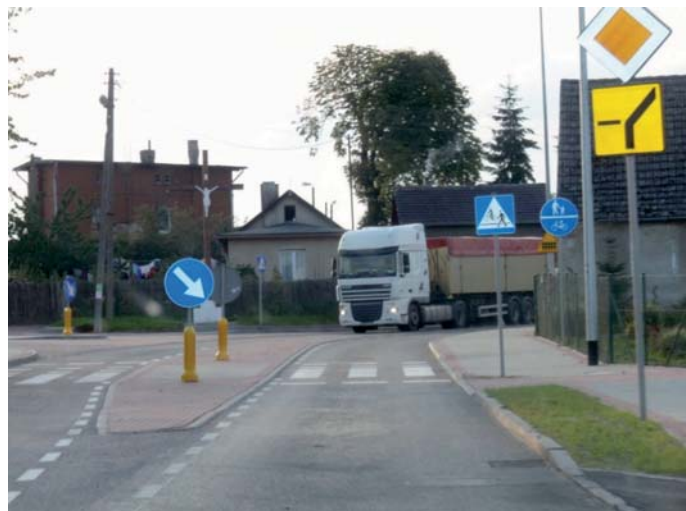
Fot. 6. Droga wojewódzka nr 122 za zakończeniem inwestycji (sierpień 2011 r.) – archiwum ZZDW [4]
