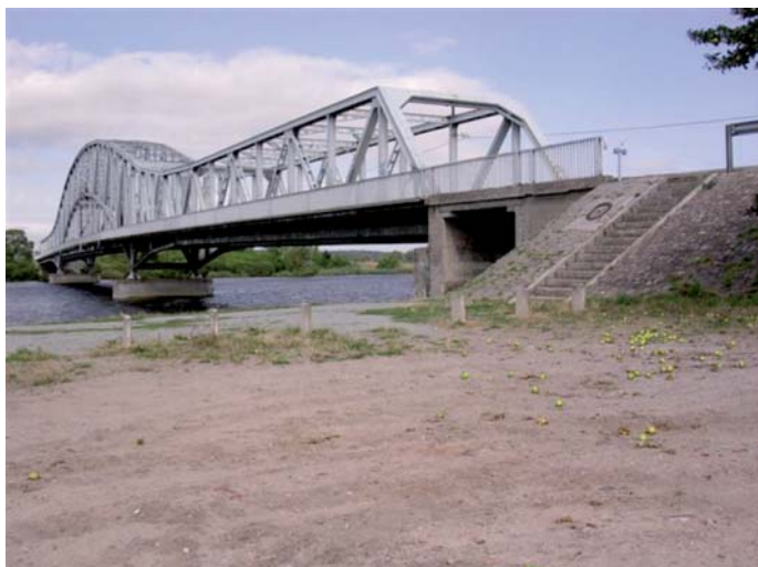
Fot. 1. Most na Odrze Wschodniej w Gryfinie przed modernizacją (sierpień 2006 r.) – archiwum ZZDW [4]
