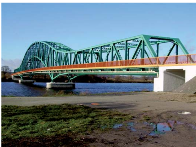
Fot. 2. Most na Odrze Wschodniej w Gryfinie po modernizacji (sierpień 2008 r.) – archiwum ZZDW [4]
