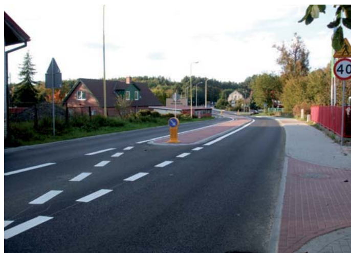
Fot. 4. Droga wojewódzka nr 115 w Pilchowie po zakończeniu inwestycji (maj 2011 r.) – archiwum ZZDW [4]
