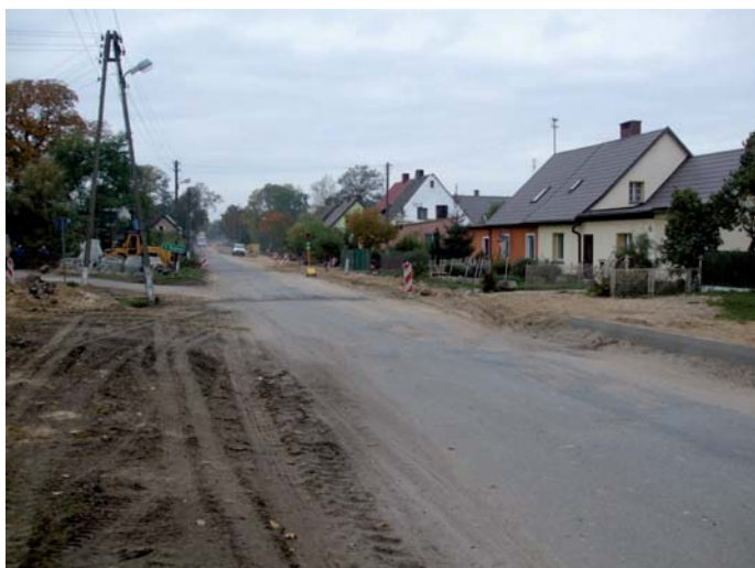
Fot. 5. Droga wojewódzka nr 122 w trakcie trwającej inwestycji (sierpień 2010 r.) – archiwum ZZDW [4]
