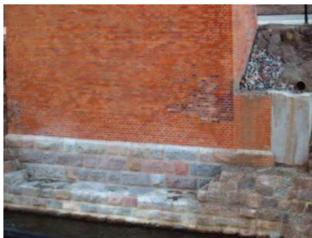
Fot. 12. Naprawa profilu odwodnienia z poziomu ulicy do rzeki Łyny
