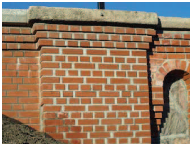
Fot. 9. Odrestaurowana elewacja wzmocnionego przyczółku
