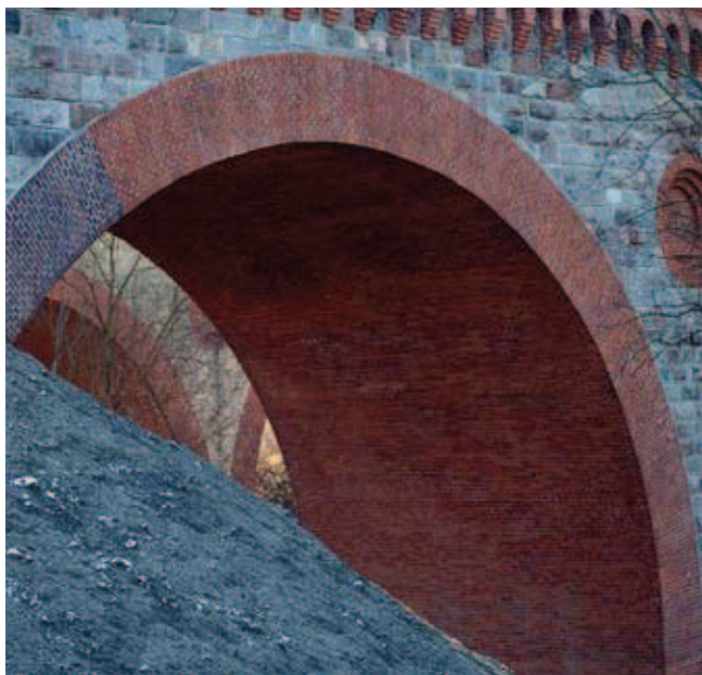
Fot. 3. Uzupelnione spoin – fragment mostu w strefie pierwszego przęsła
