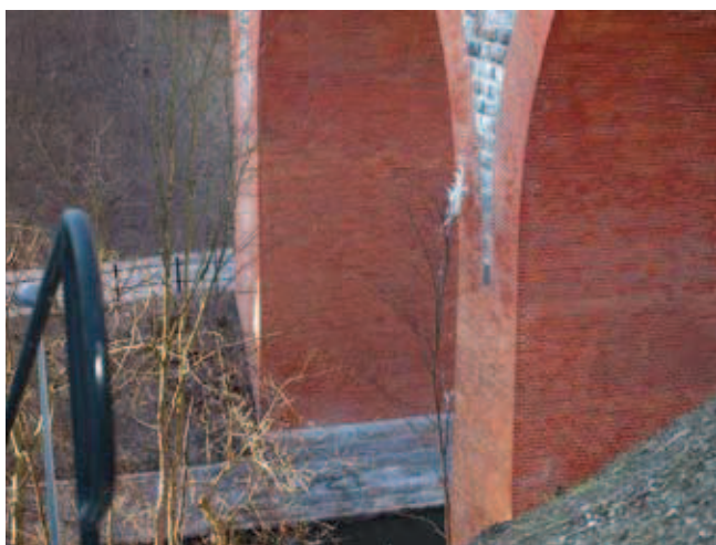
Fot. 5. Usunięcie malowań typu graffiti z filarów wiaduktu
