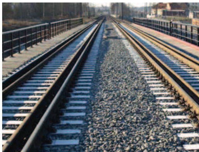
Fot. 10. Odnowione torowisko
