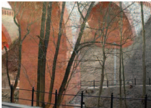
Fot. 14. Łukowa konstrukcja przęseł widziana z poziomu ul. Wyzwolenia
