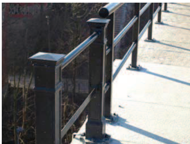
Fot. 11. Balustrada po rewitalizacji – przyczółek mostu
