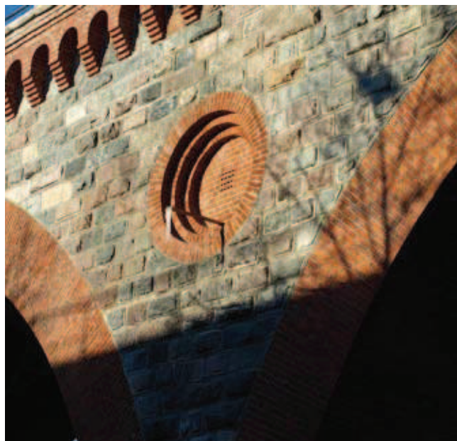
Fot. 4. Naprawa dekoracyjnej rozety wykonanej z wątku ceglanego
