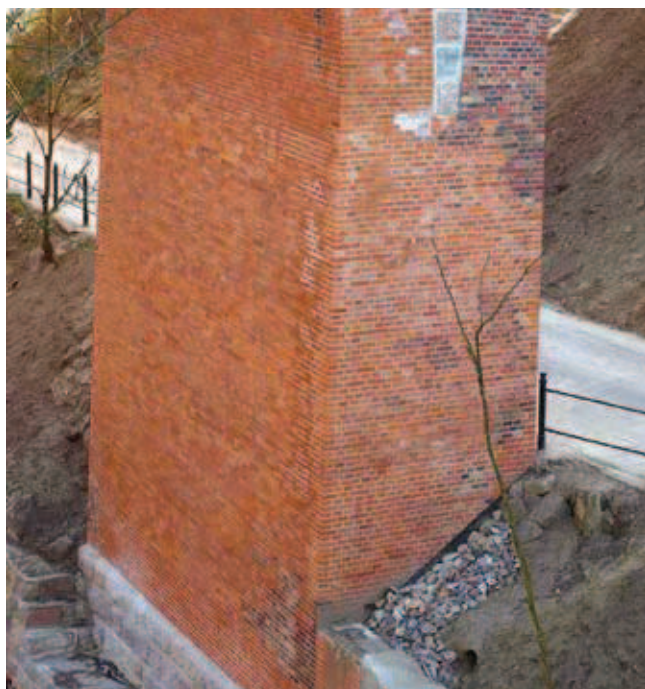
Fot. 1. Oczyszczenie powierzchni cegieł i ciosów kamiennych
