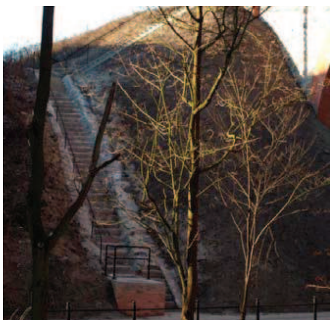
Fot. 13. Schody z ulicy na poziom wiaduktu kolejowego
