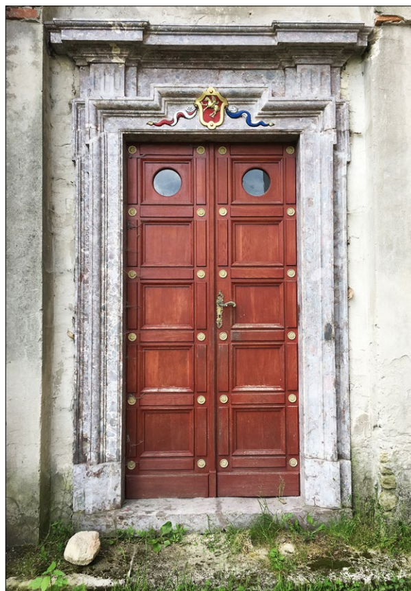
Ryc. 6. Pałac Dzięki w Wiązownicy-Kolonii, portal przeniesiony z Podzamcza Chęcińskiego; fot. R. Marcinek 2019.
