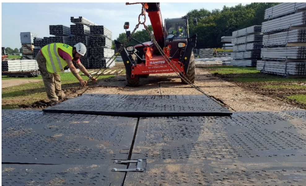
Rys. 3. Układanie drogi czasowej z płyt L-mat z użyciem sprzętu
