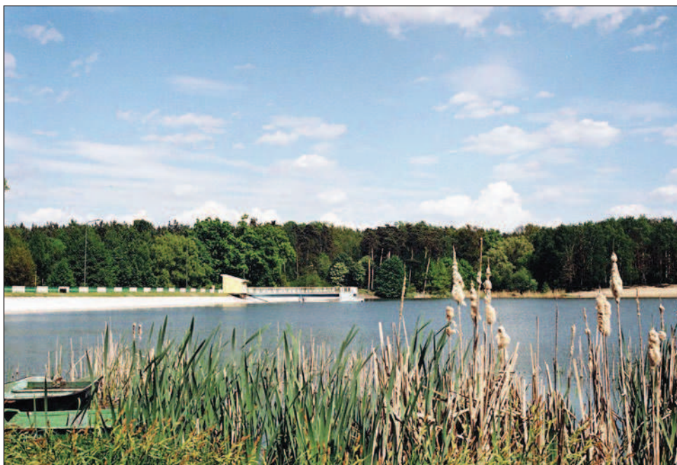
Fot. 2. Zbiornik Gołuchów od strony zachodniej, w głębi widoczna zapora i wieża przelewową
