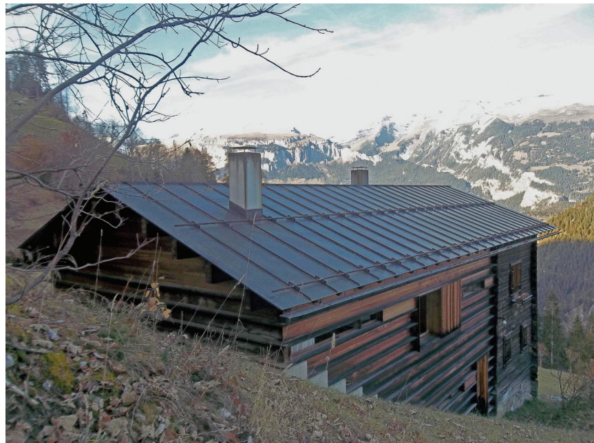
Fot. 4. Peter Zumthor, Gugalun House, Versam. 1993–1994. Nowa część została dostawiona od strony południowo-zachodniej i ukryta za starym domem oraz częściowo w stoku wzgórza
