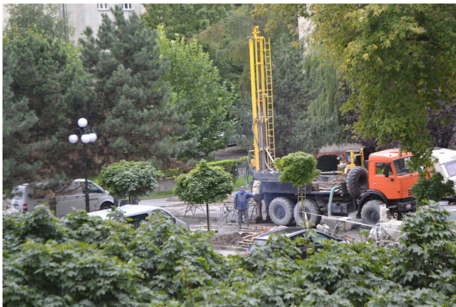
Rys. 6. Wiercenie nowych wymienników otworowych na AGH w 2017 r. Fig. 6. Drilling of new borehole heat exchangers at AGH in 2017
