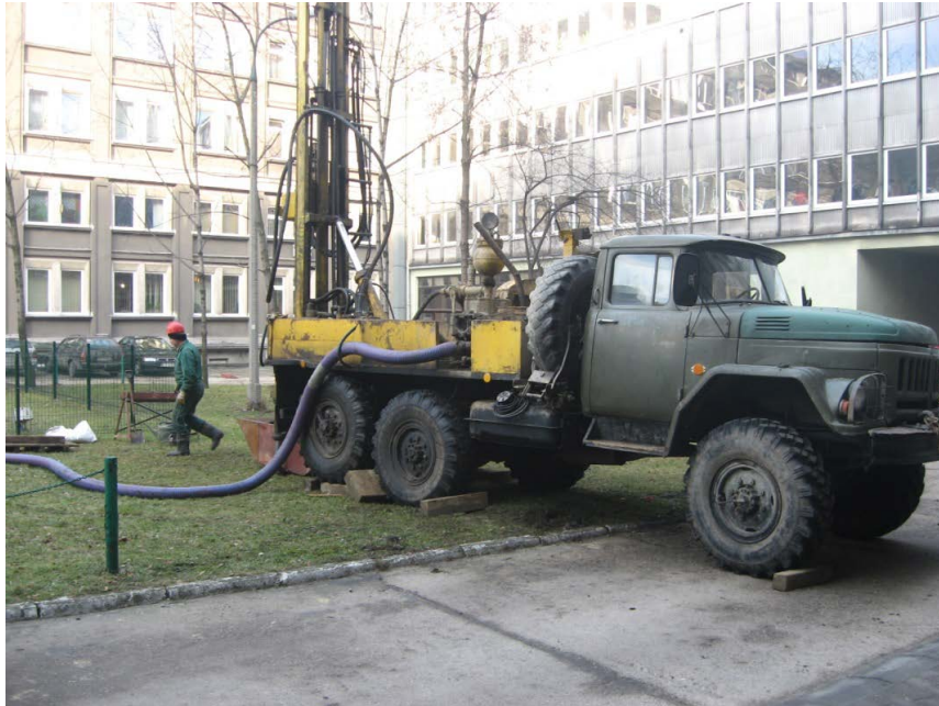
Rys. 5. Wiertnica URB 2A wykonująca pierwszy otwór w celu zainstalowania rur wymiennika ciepła w 2008 r. Fig. 5. URB 2A drilling rig performing the first borehole to install the heat exchanger pipes in 2008
