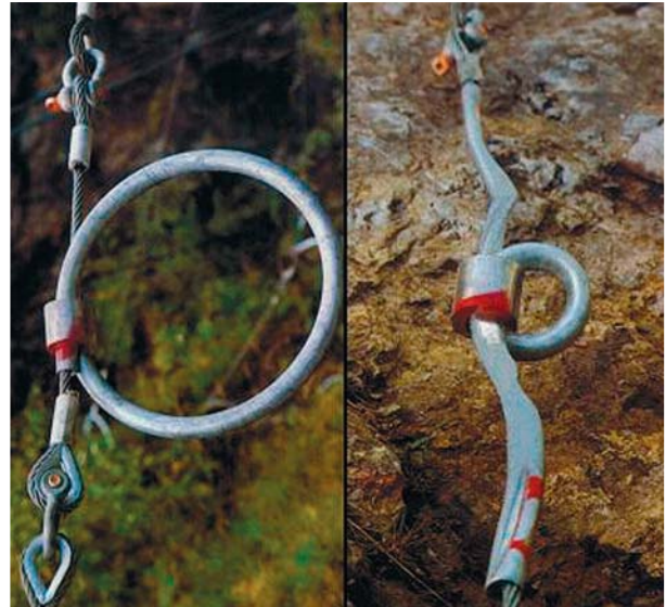
Fig. 9. Brake rings
