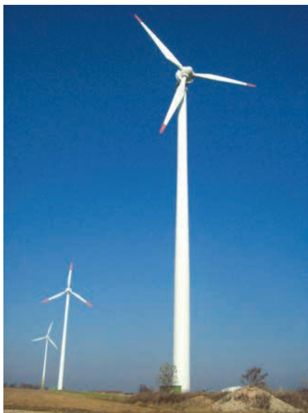
Fot. 1. Przedmiot badań – turbiny o mocy po 0,5 MW produkcji firmy Enercon GmbH (fot. G. Wągrowski)
