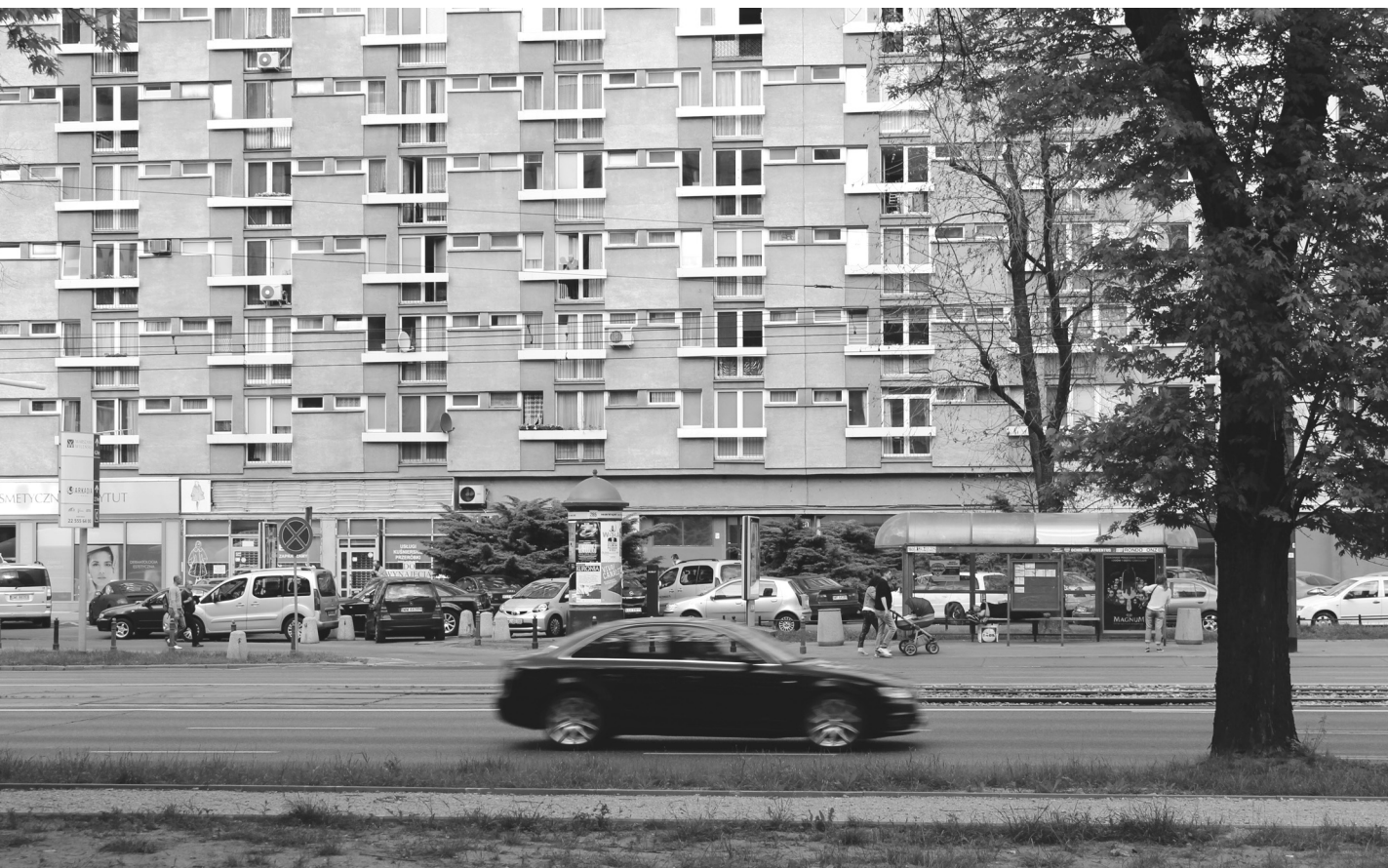
Ryc. 3. Osiedle Za Żelazną Bramą w Warszawie - zaniedbana roślinność; fot.: Z. Glińska (2015). Fig. 3. The Behind The Iron Gate housing estate in Warsaw – greenery negligences; photo: Z. Glińska (2015).
