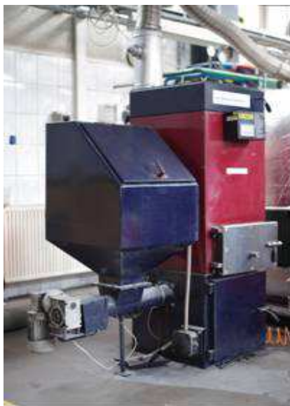
Rys. 1. Kocioł węglowy z podajnikiem automatycznym
