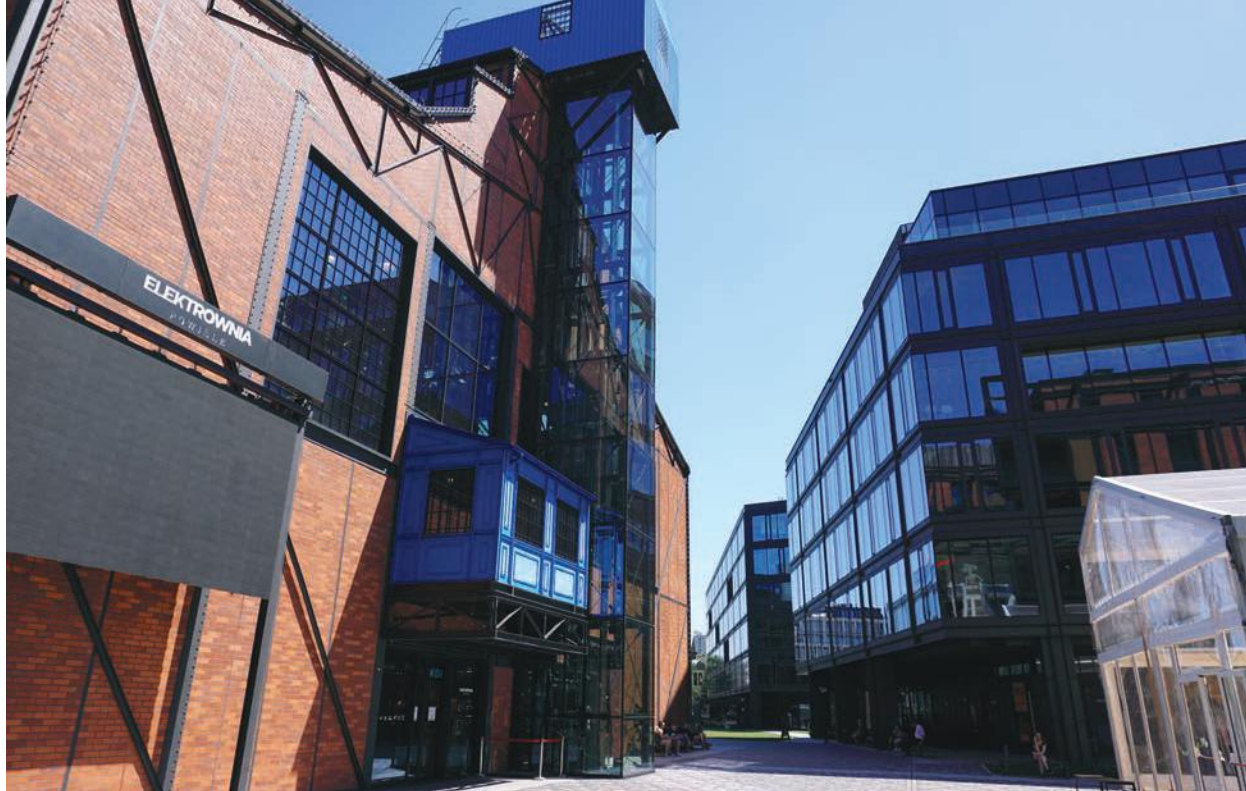
il.2. Elektrownia Powiśle/autor zdjęcia Anita Orchowska ill.2. Powiśle Power Station/ author of photos Anita Orchowska
