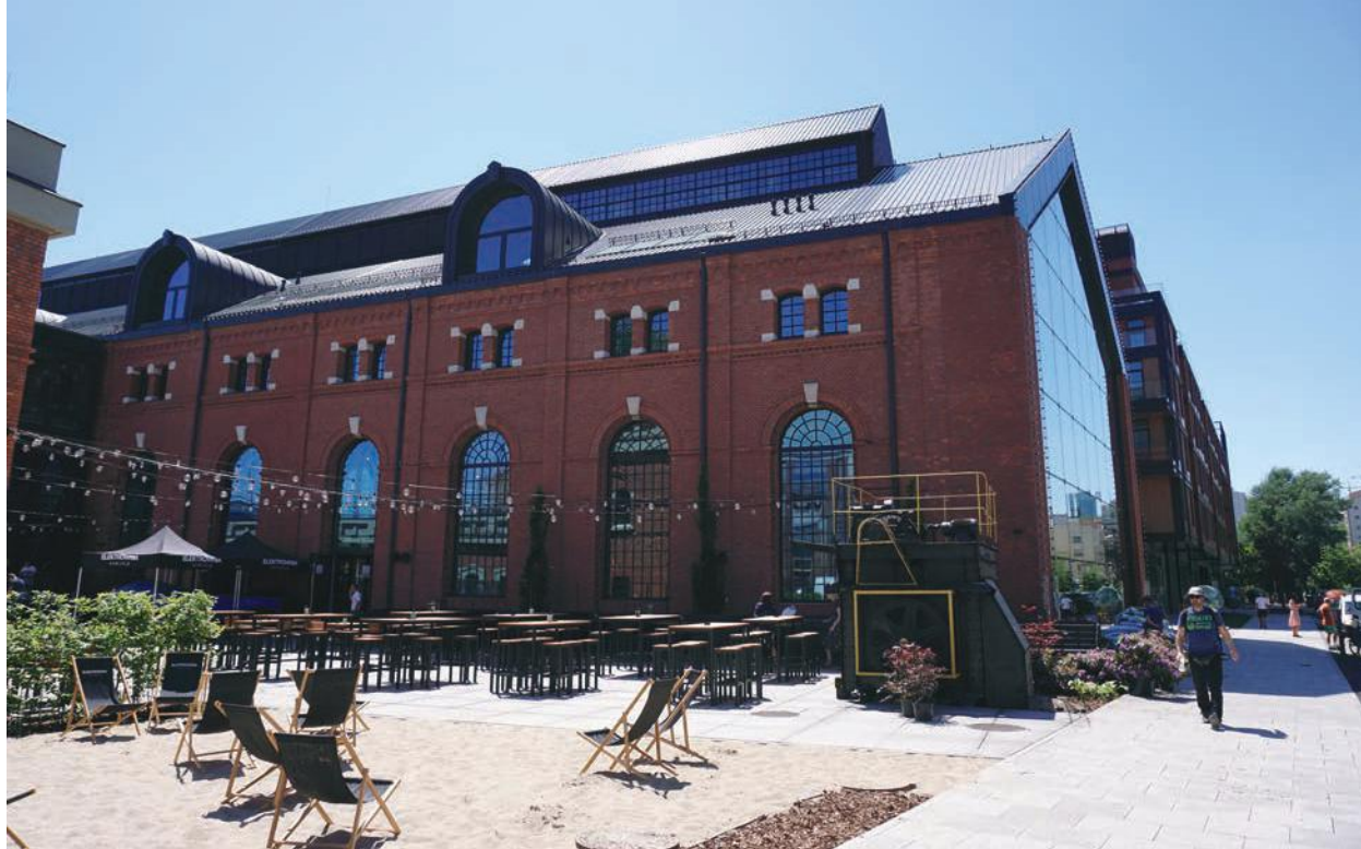
il.3. Elektrownia Powiśle/autor zdjęcia Anita Orchowska ill.3. Powiśle Power Station/ author of photos Anita Orchowska
