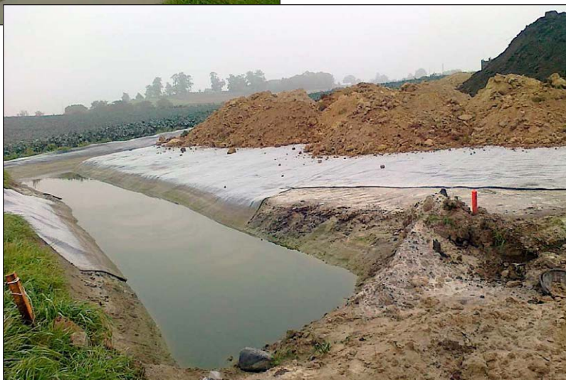
Fot. 4. Wykonywanie rowu opaskowego i układanie gruntu na macie bentonitowej, wrzesień 2014 r., fot. Z. Staszewski
