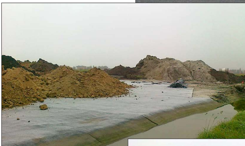
Fot. 3. Układanie gruntu na macie bentonitowej, wrzesień 2014 r., fot. Z. Staszewski
